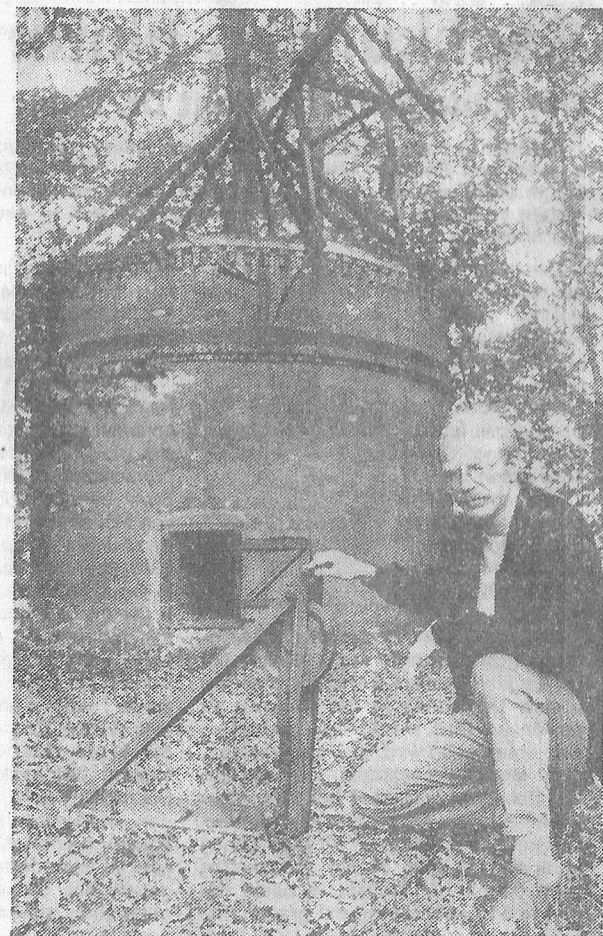
... und nach der Brandstiftung.
